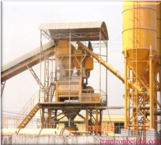
Trạm trộn bê tông 120 m 3 /giờ
