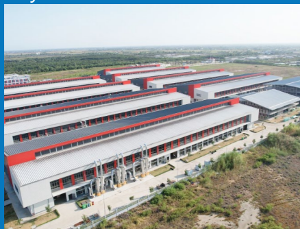
CỤM CÔNG NGHIỆP GIA THUẬN 1
