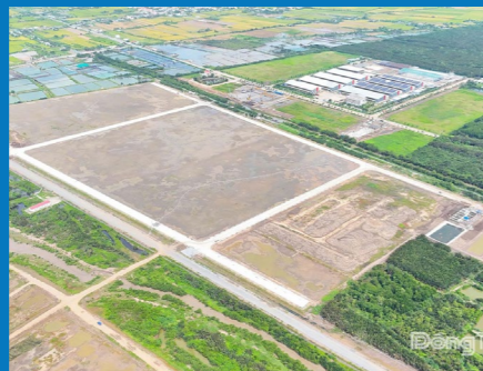
CỤM CÔNG NGHIỆP GIA THUẬN 2
