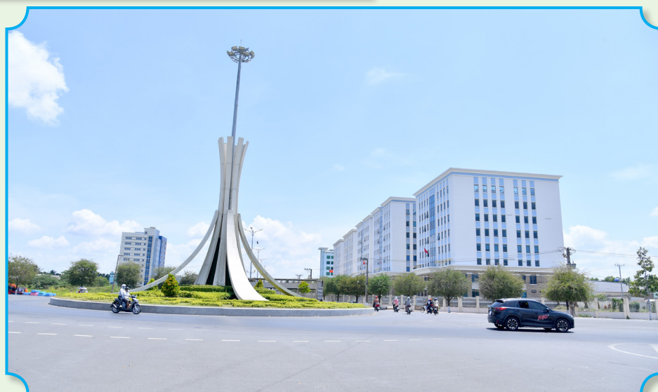
Cung cấp các sản phẩm từ bê tông cho Trung tâm Hành chính tỉnh Tiền Giang
