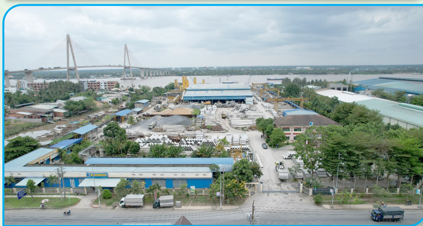
Nhà máy Bê tông TICCO (Mỹ Tho và Tân Phước)
