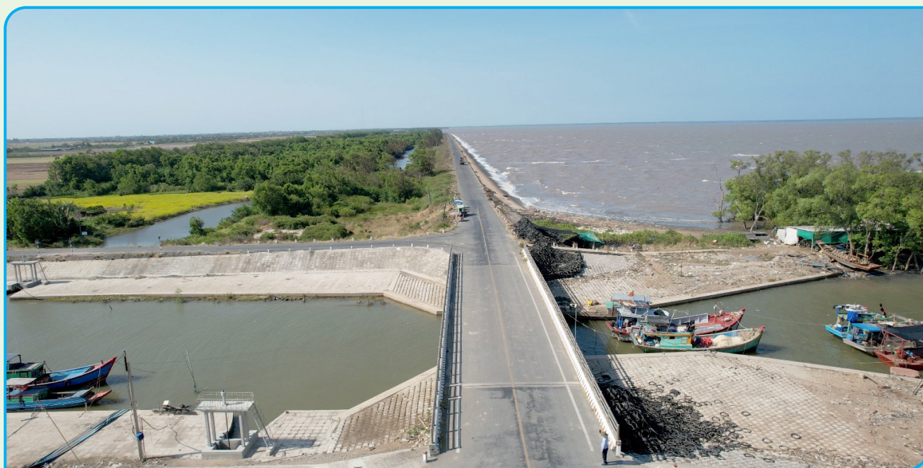
Kè biển Tân Thành - Vàm Láng Gò Công Đông - Tiền Giang
