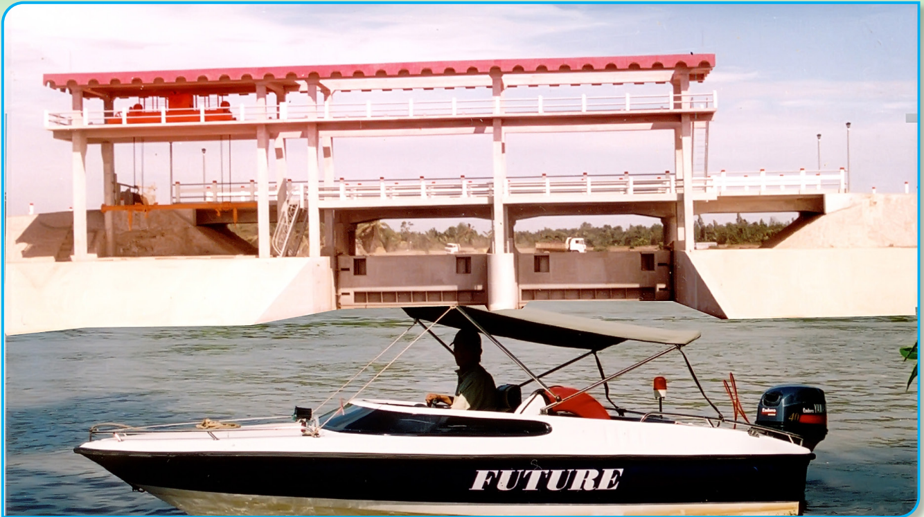
Cống Chà Và - Cầu Ngang - Trà Vinh
