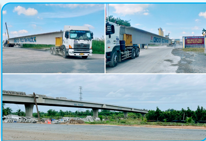
Cung cấp sản phẩm dầm cầu Super T cho Dự án cao tốc Trung Lương - Mỹ Thuận và Dự án cầu Rạch Miễu 2
