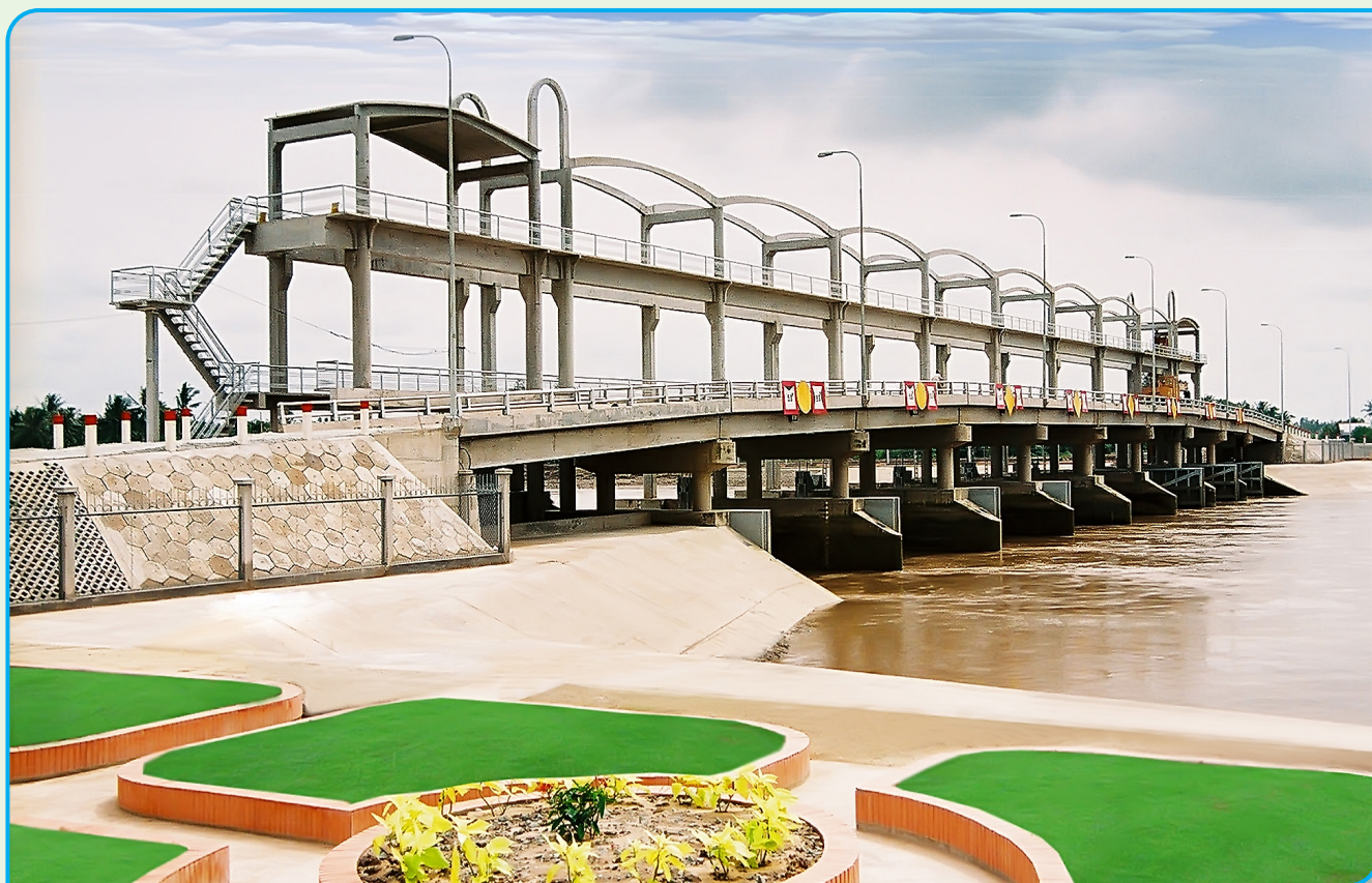
Cống Cần Chông - Cầu Kè - Trà Vinh
