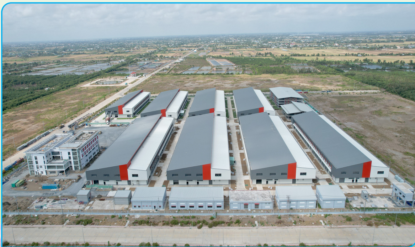
Dự án Cụm công nghiệp Gia Thuận 1
