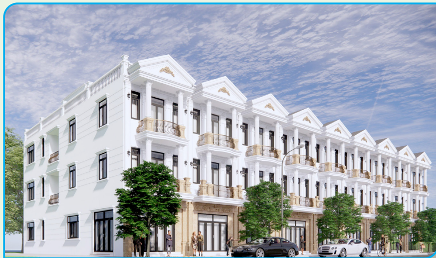
Khu dân cư đường Nguyễn Trọng Dân nối dài
